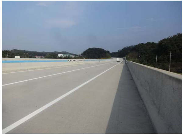
교량 상부 전경
