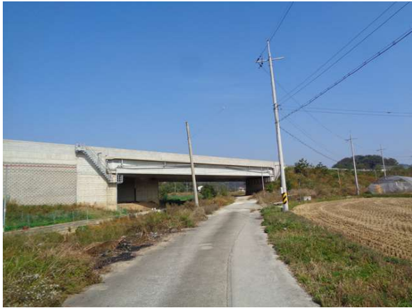
교량 측면 전경
