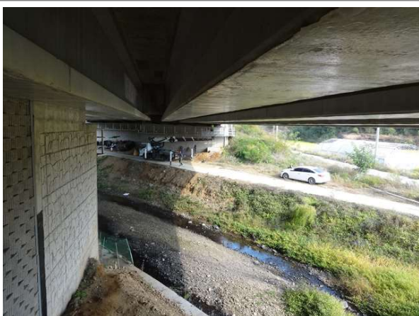
교량 하부 전경
