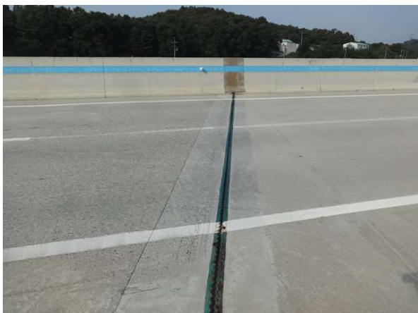
교량 상부 전경
