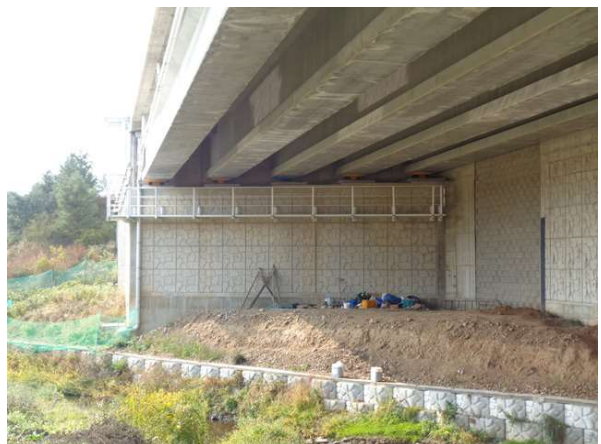
교량 하부 전경
