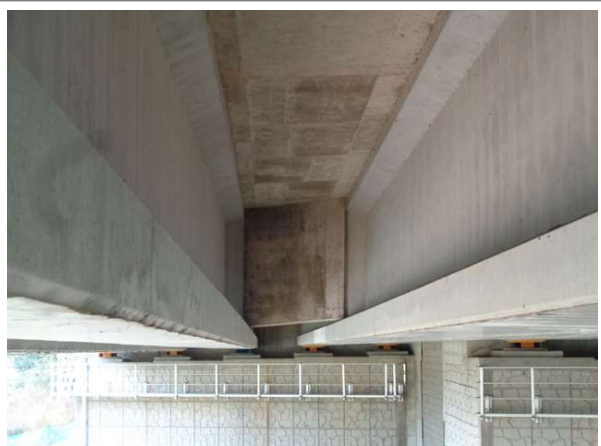
교량 거더 전경
